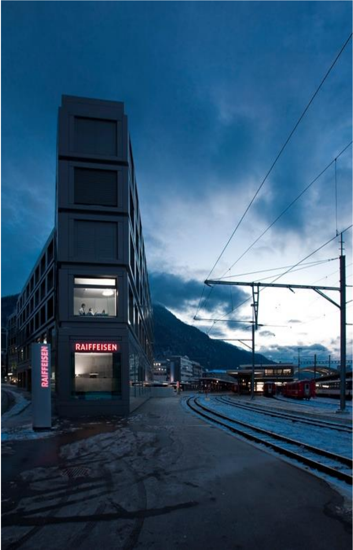
Banque Raiffeisen Bündner Rheinthal, Giubini Architekten, Coire
